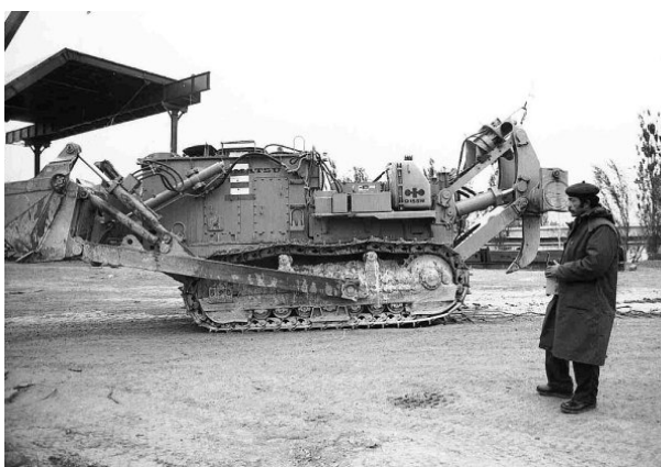
Бульдозер Komatsu с дистанционным управлением
